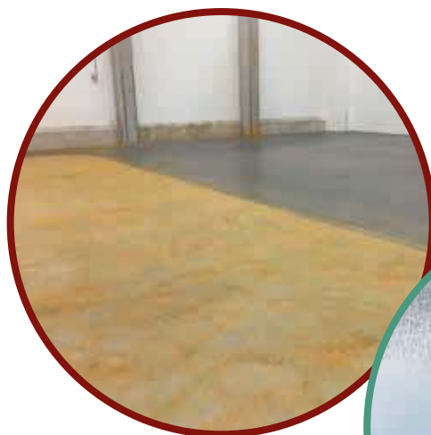
Roestwater verwijderen op gepolierd beton
