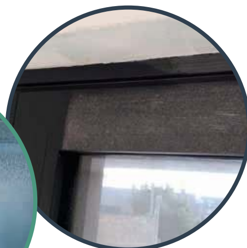
Pleisterresten verwijderen van aluminium raamprofielen
