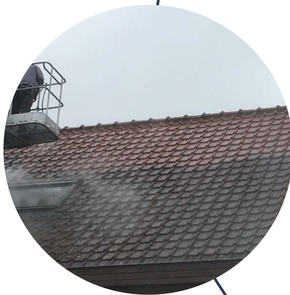
Reinigen en ontmossen van dak
