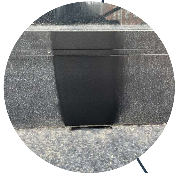
Kalk- en cementvlekken verwijderen van zwarte aluminium raamprofielen.
