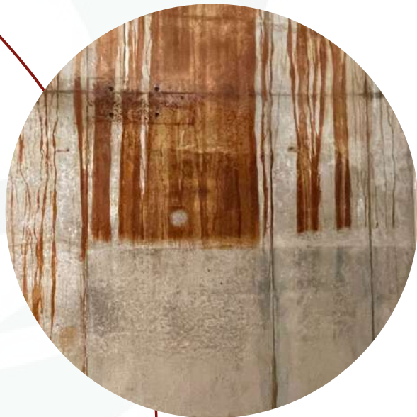
Roest verwijderen van betonwanden.
