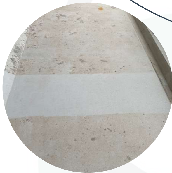
Verwijderen van hardnekkige vervuiling door luchtgommen op wit beton
