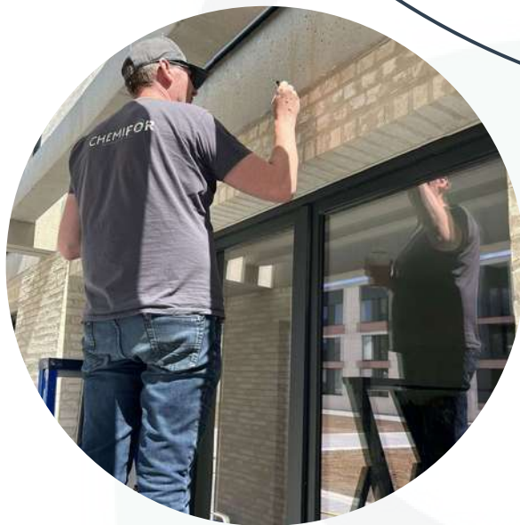
Verwijderen van roest op baksteengevel.
