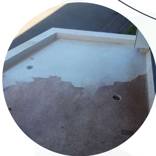
Verwijderen van roest en vervuilingen op balkon uit wit beton.
