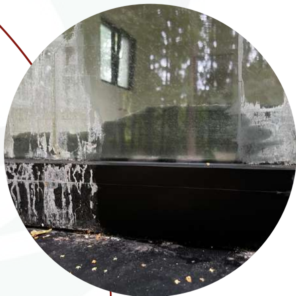
Verwijderen van cement- en kalkvlekken op zwarte aluminium raamprofielen.
