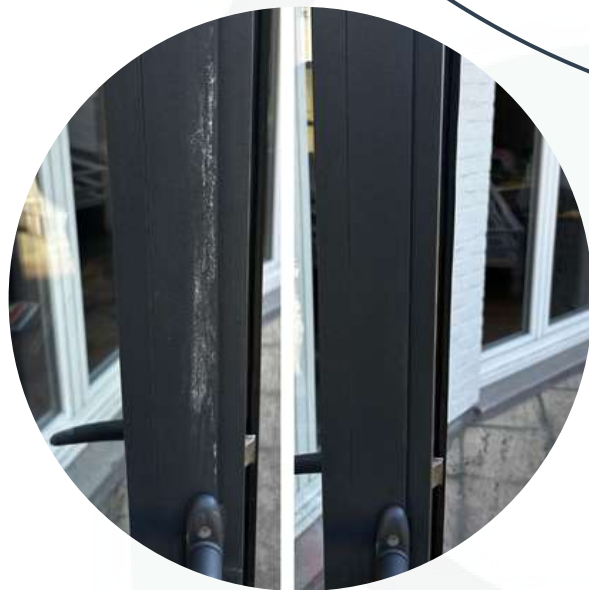
Lijm verwijderen van aluminium raamprofielen
